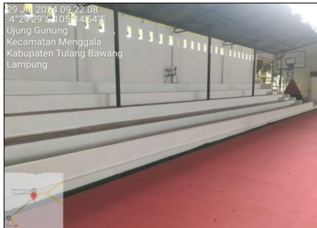
Rehabilitasi Lapangan Tenis Indoor Kec. Menggala
