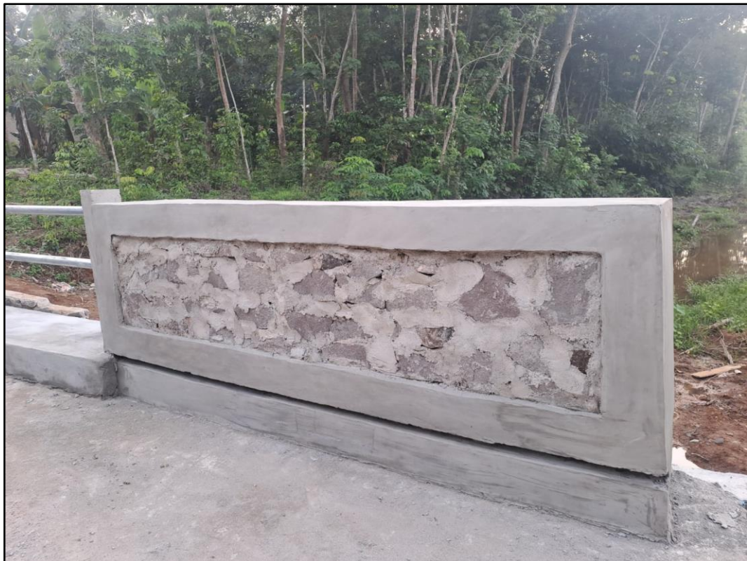
Rehabilitasi/Penggantian Box Culvert Kec. Meraksa Aji
