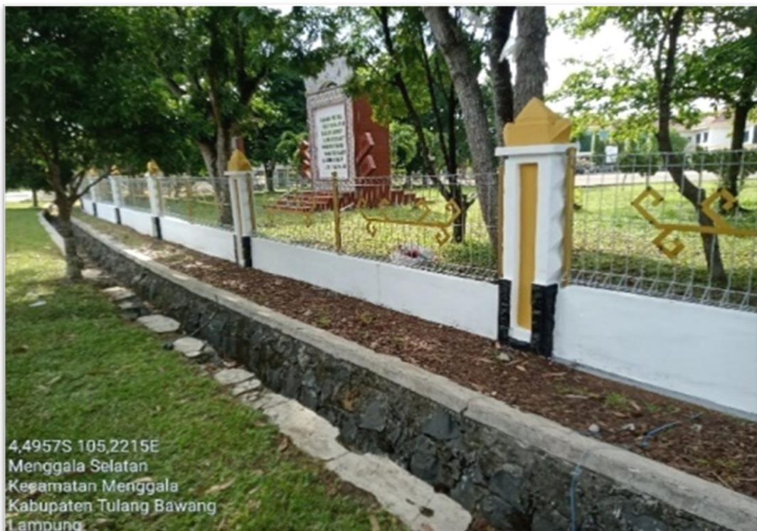
Rehabilitasi Gapura Pemda Tulang Bawang
