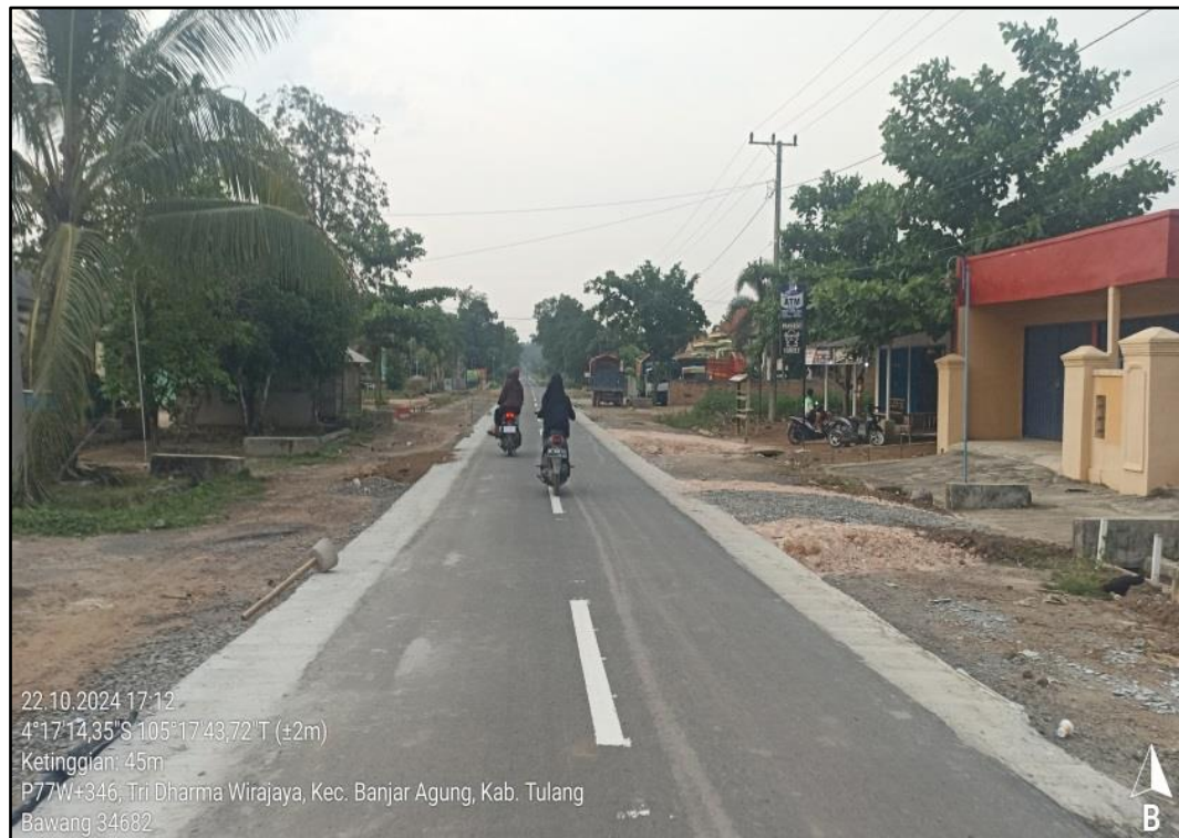
Pemeliharaan Berkala /Peningkatan Ruas Jalan Tri Dharma / Wirajaya - Sp. III/Sp. BL Kecamatan Banjar Agung (DBH SAWIT)
