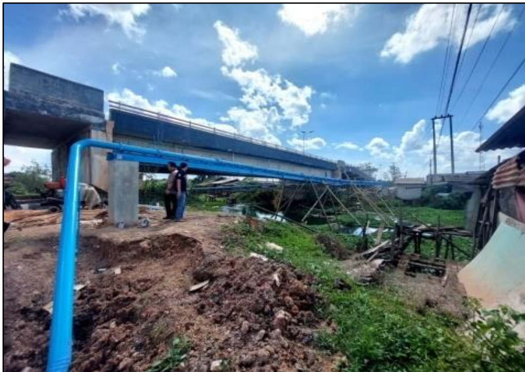
Rehabilitasi Sarana SPAM dan Jaringan Perpipaan SPAM Unit Pelayanan Simpang Mesir Kecamatan Rawajitu Selatan
