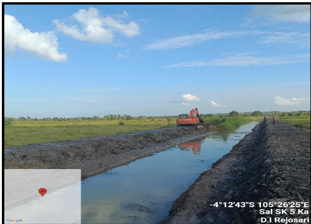
Pembangunan jaringan irigasi Daerah irigasi rawa Rejosari Kampung Rejosari Kecamatan Penawar Tama
