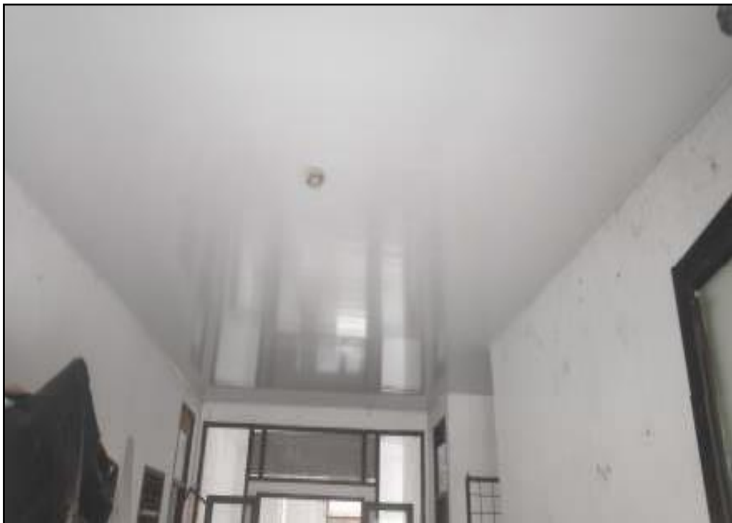
Rehabilitasi Kantor Dinas PUPR Kabupaten Tulang Bawang
