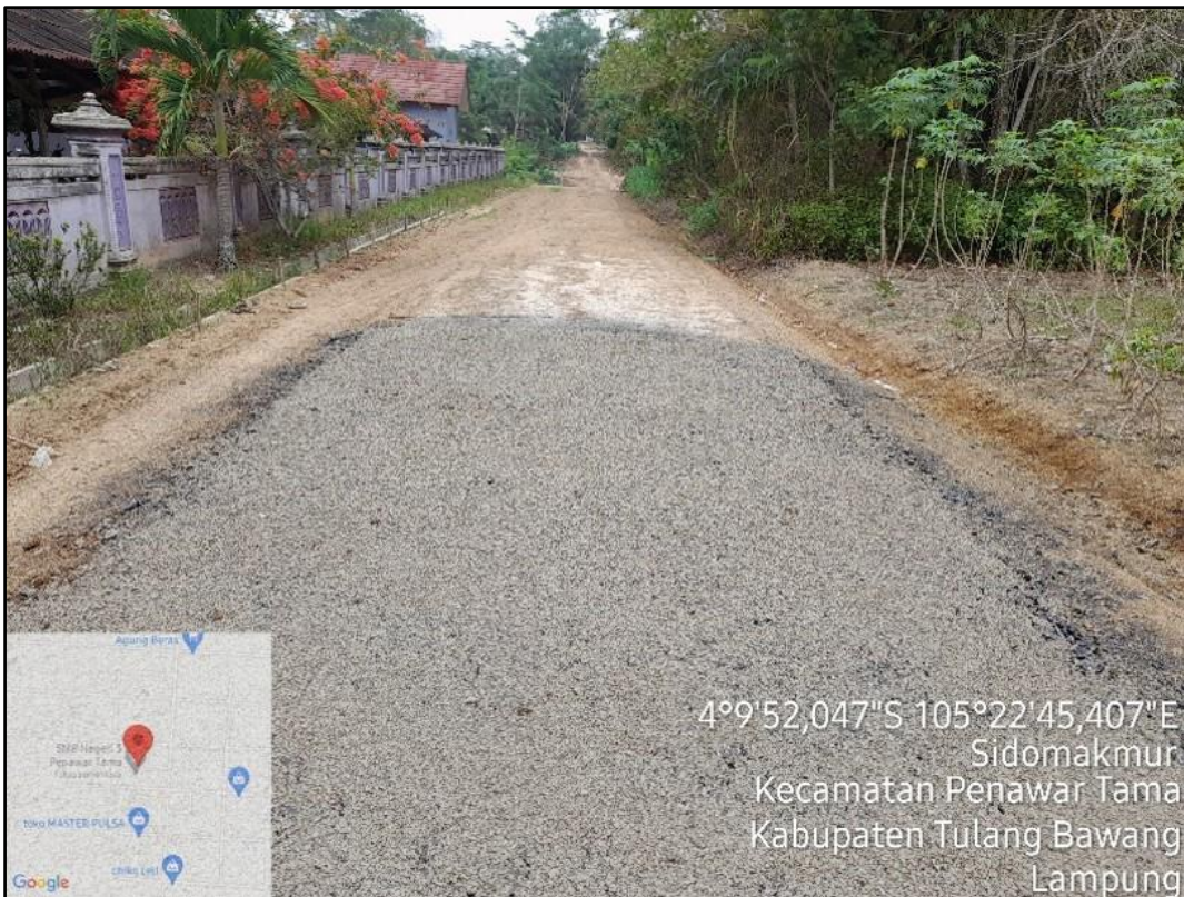
Peningkatan Jalan Menuju SMPN 3 Kec. Penawar Tama
