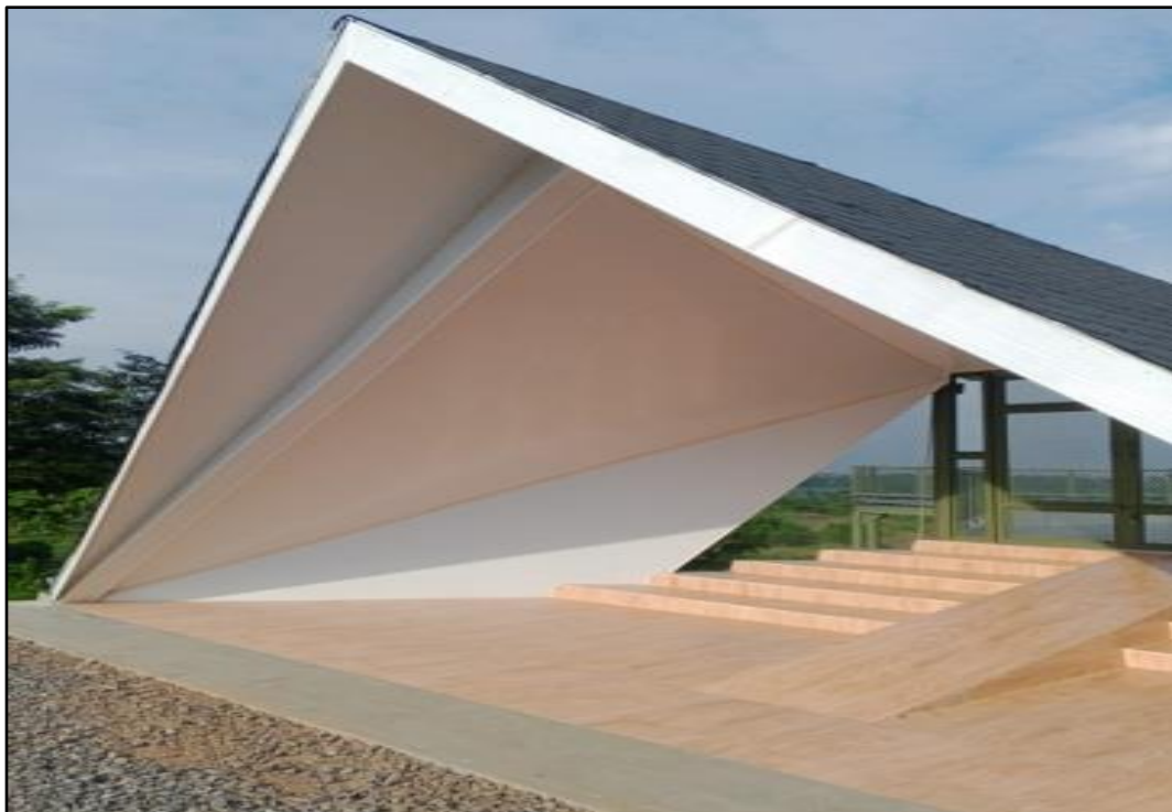
Pembangunan Jembatan Pandang pada Kawasan Cakat Nyenyek Kecamatan Menggala Timur
