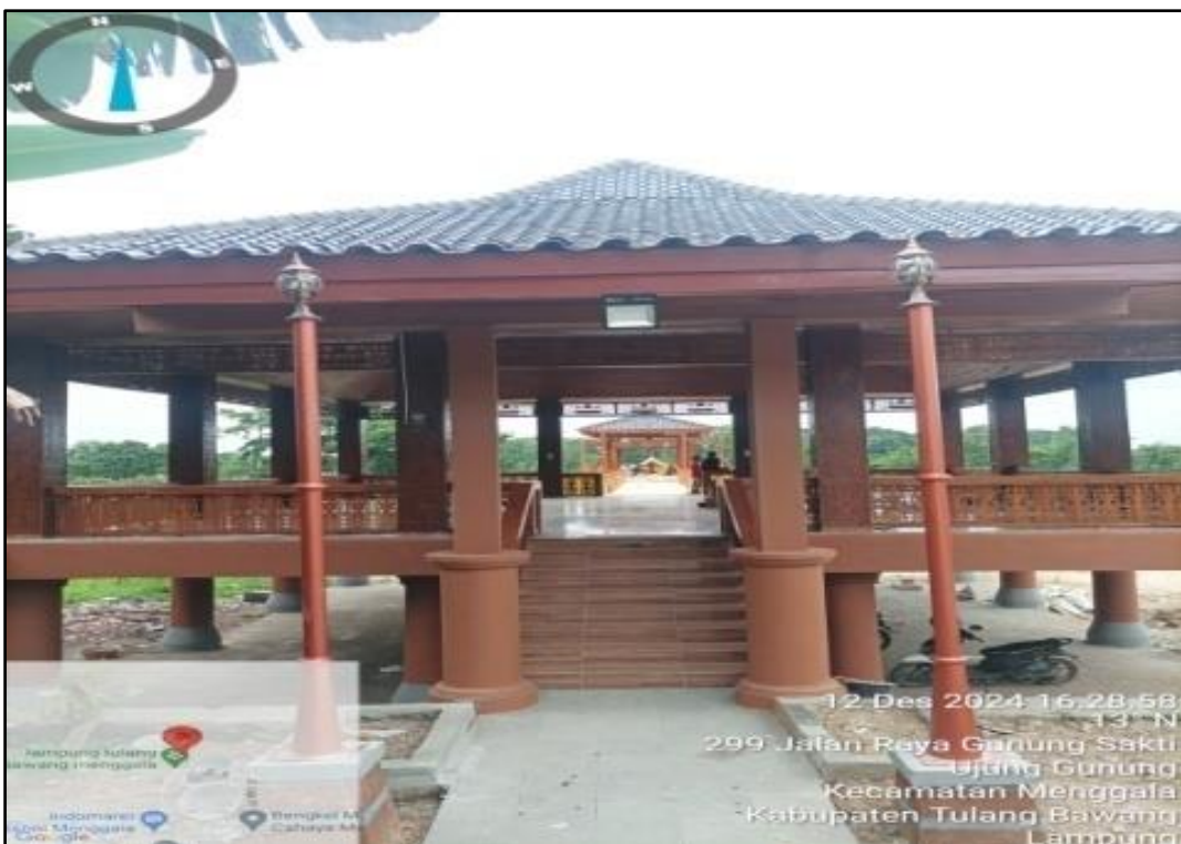
Rehabilitasi Bangunan Tangga Raja Menggala Kec. Menggala
