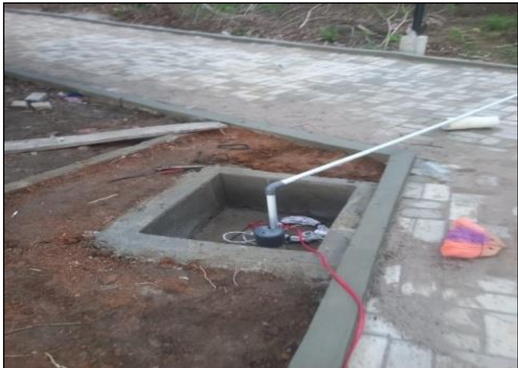
Pembangunan Sarana Air Bersih dan Pelengkapannya di Jalan Pemokow Menggala Kecamatan Menggala
