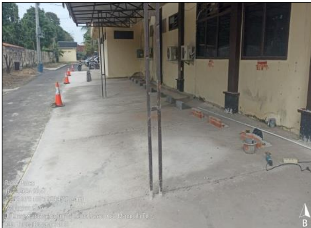
Pembangunan Area Parkir Gedung Polres Tulang Bawang
