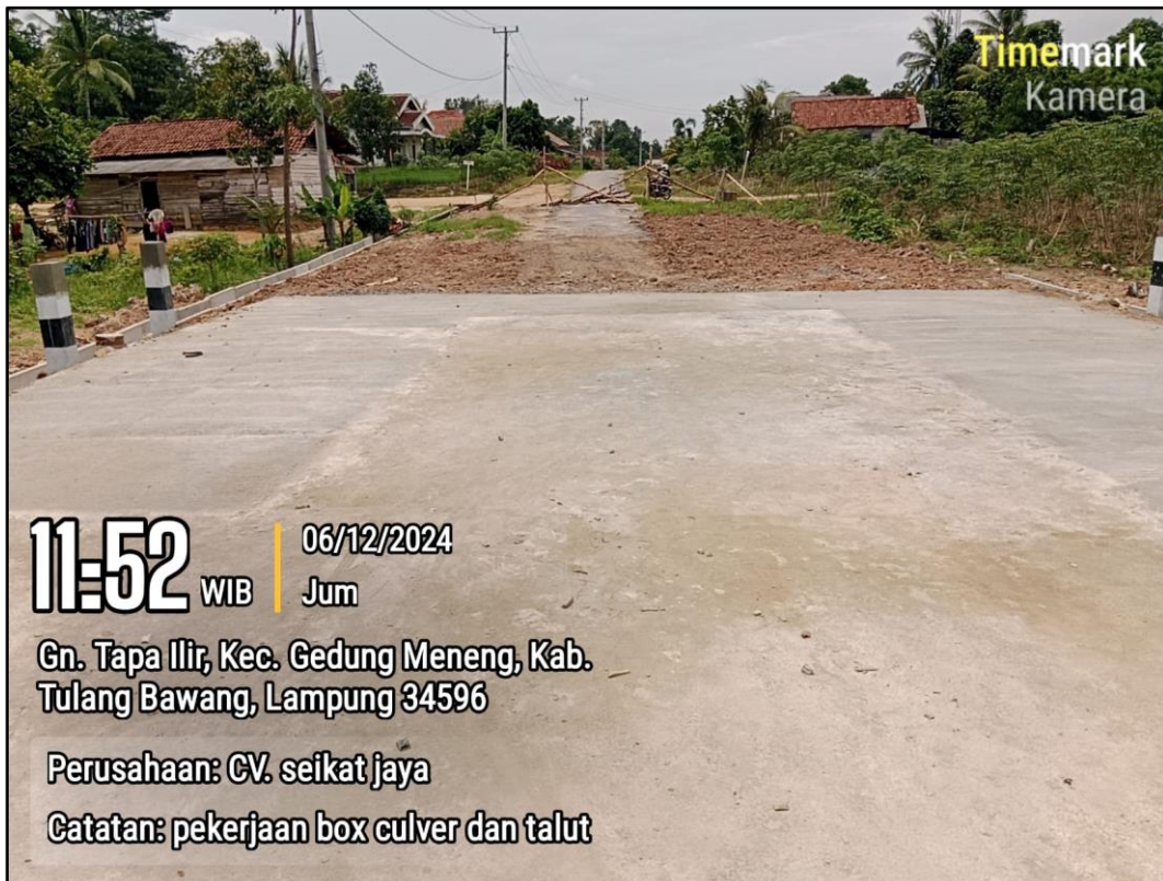
Pembangunan Box Culvert dan Talud Kampung Gunung Tapa Kecamatan Gedung Meneng
