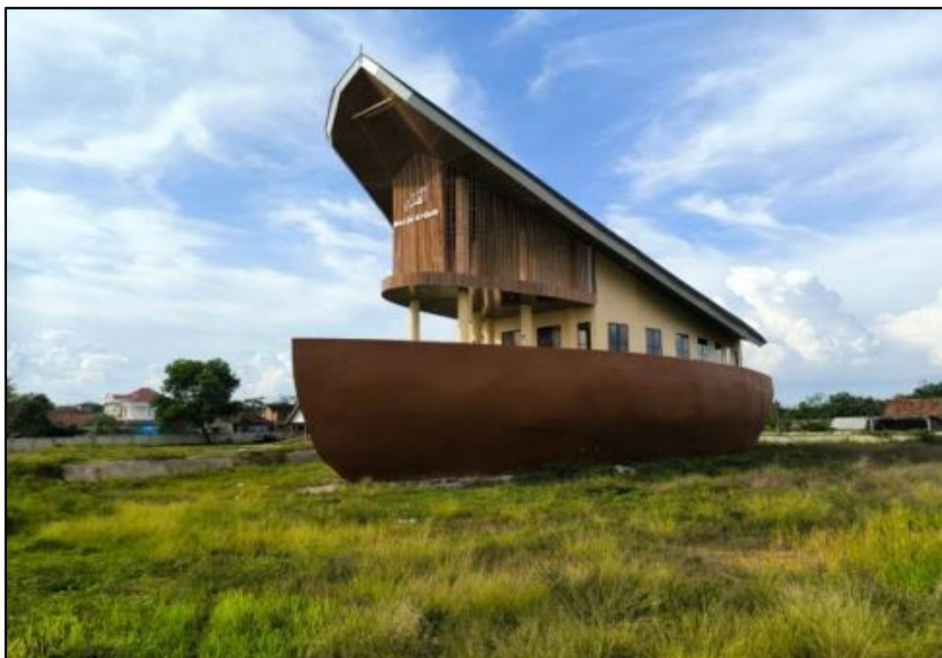
Pekerjaan Lanjutan Bangunan Kapal Pada Taman Simpang Penawar
