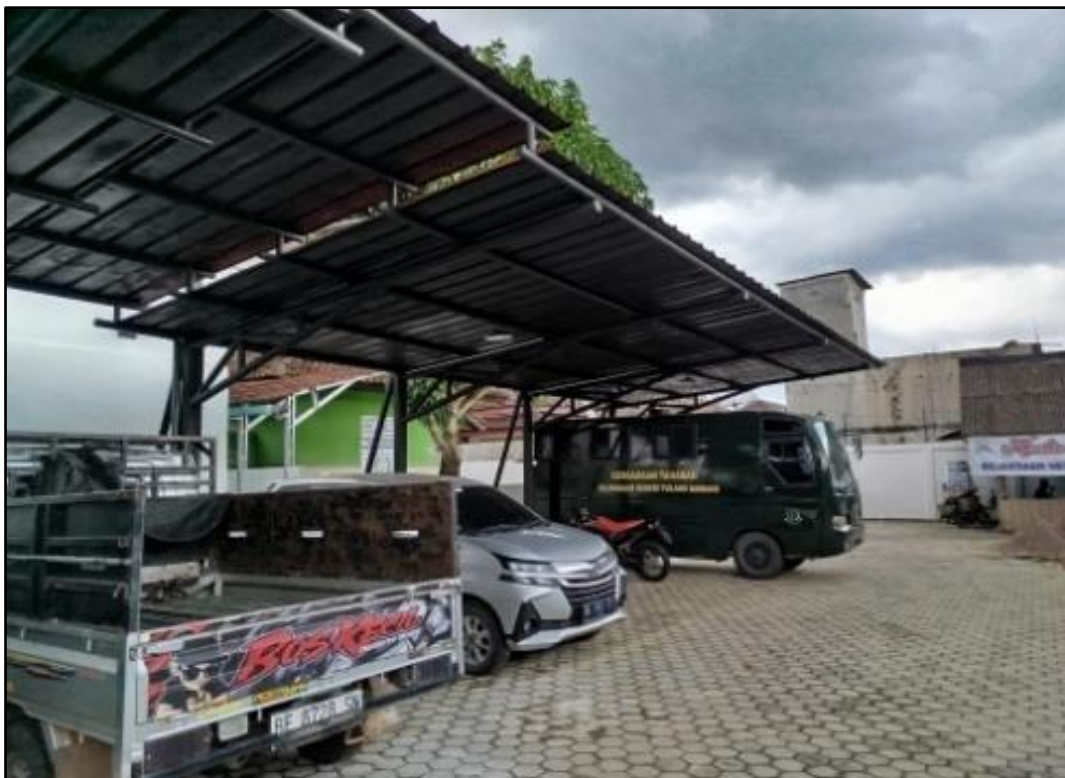
Pembangunan Kanopi Parkir Barang Bukti Kejari Tulang Bawang
