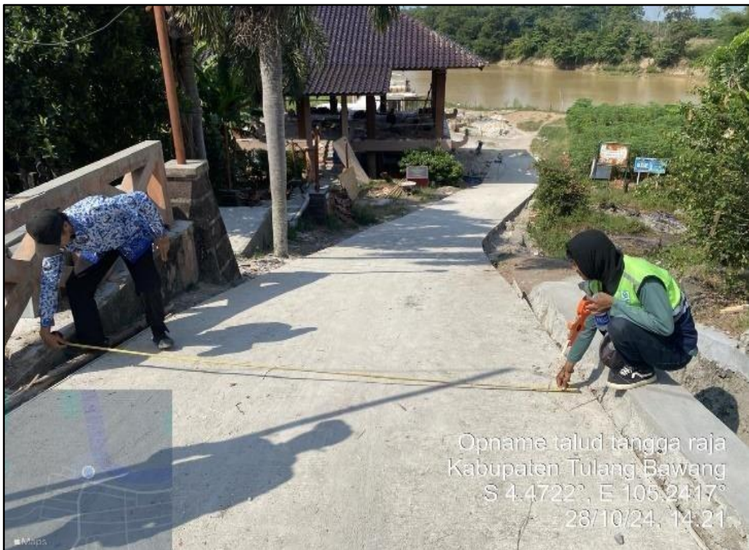
Rehabilitasi Talud Drainase Jalan Tangga Raja Straat I Kel. Ujung Gunung Kec. Menggala
