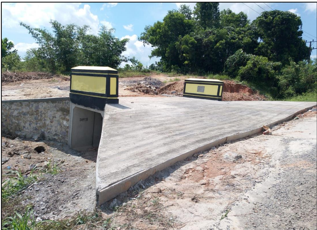
Pembangunan Box Culvert Cakat Kec. Menggala Timur
